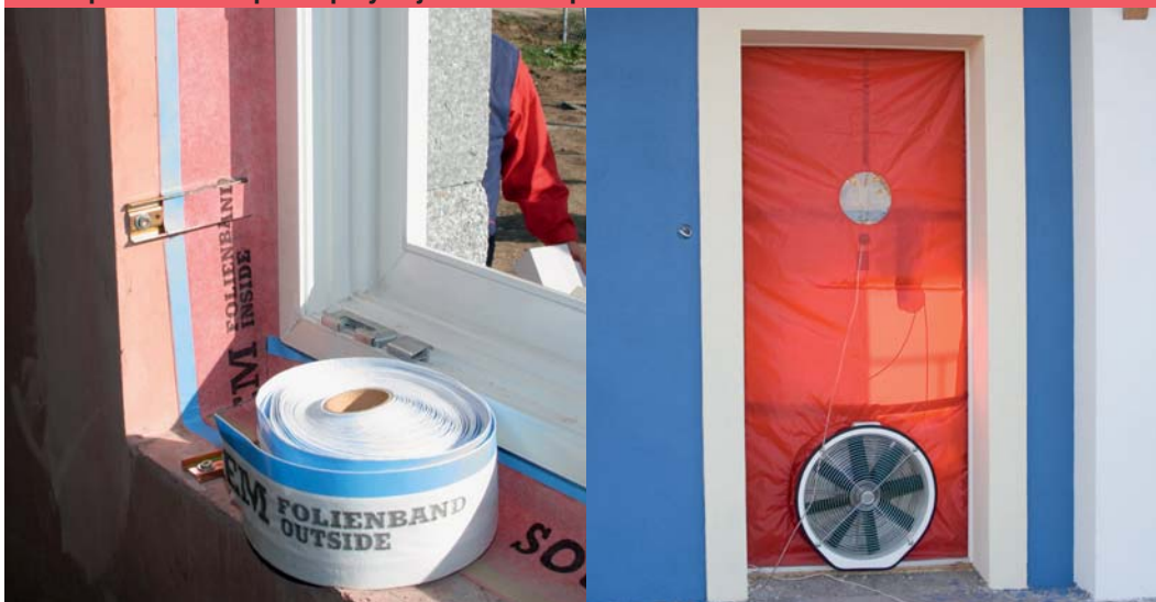
Folia paroszczelna przed przyklejeniem oraz próba ciśnieniowa
