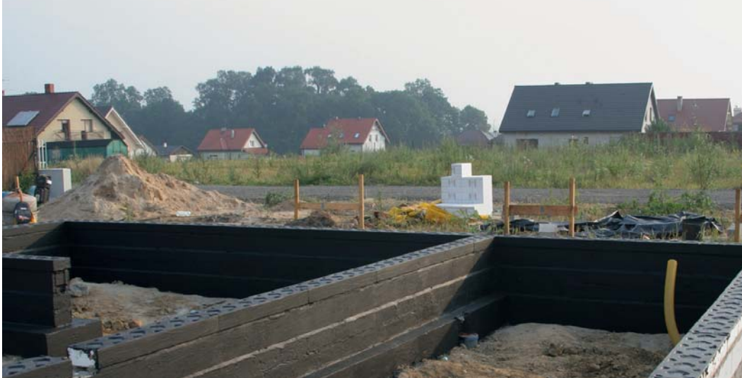
Montaż prefabrykatów keramzytobetonowych
