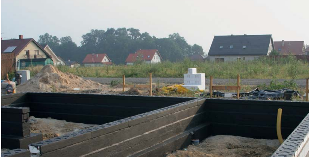
Montaż prefabrykatów keramzytobetonowych
