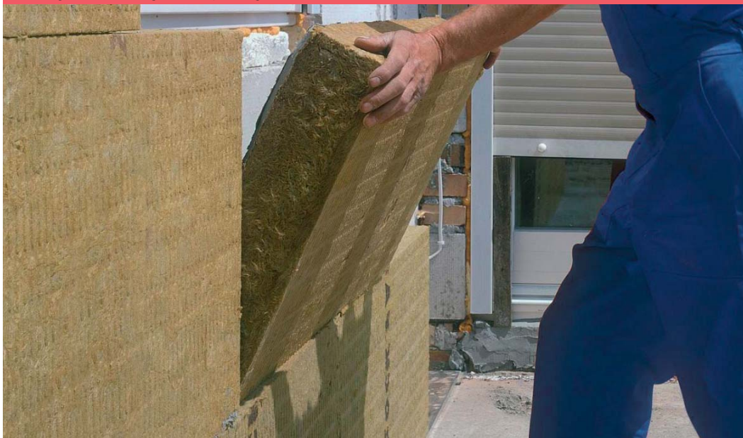
Docieplenie ściany zewnętrznej
